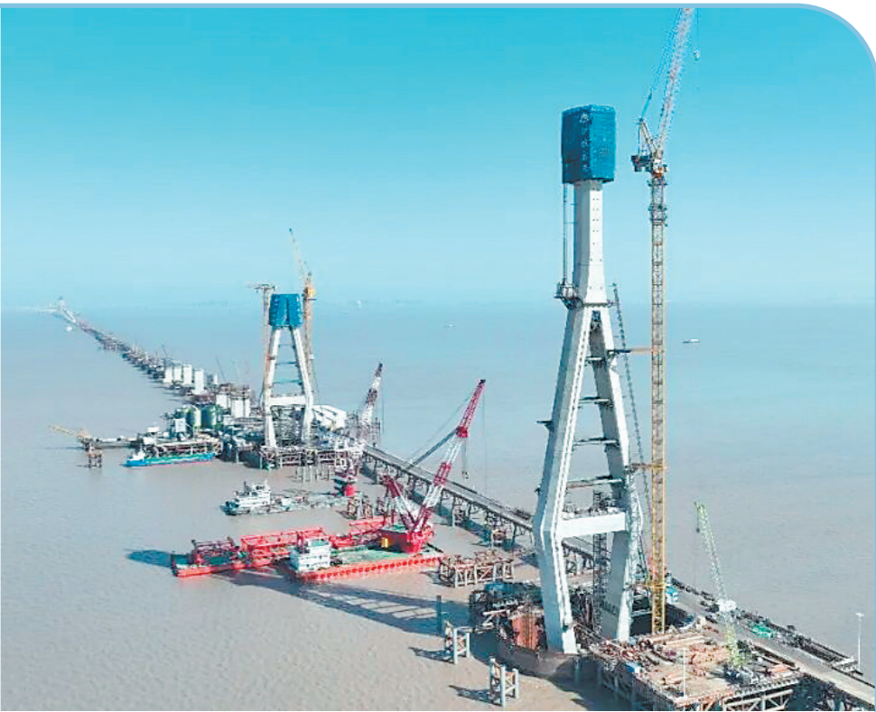
中联重科L630-50动臂塔机现场进行160号主塔吊装。中联重科供图
