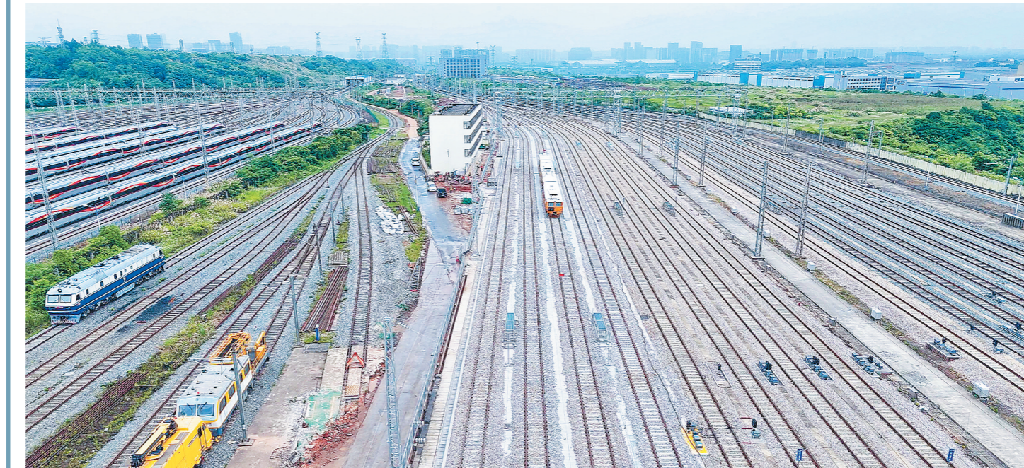
6月30日,长沙动车运用所扩建存车线一期工程全面完工并正式投运。长沙晚报全媒体记者 吴鑫矾 通讯员 谢敏 周佳鑫 摄影报道
